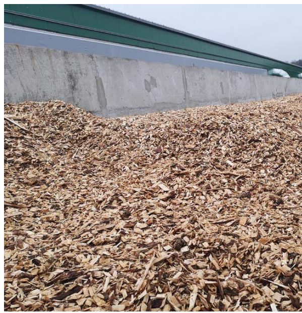
Рисунок 2.5 – Заполнение биофильтра и система вентиляции
